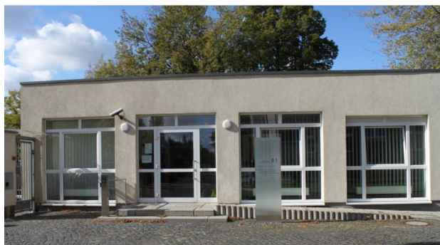
M8: Außenansicht der GfZL, Permoserstraße © GfZL
