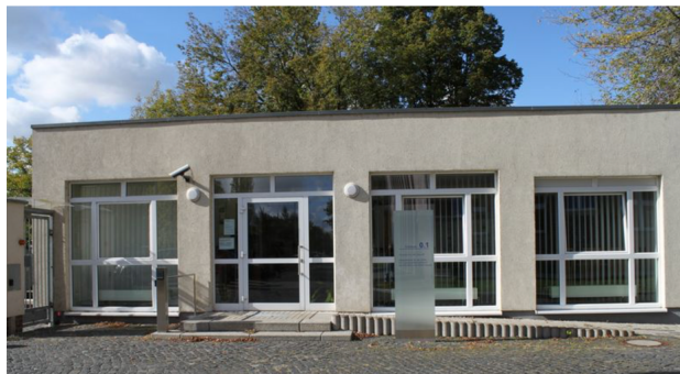
M8: Außenansicht der GfZL Permoserstraße © GfZL
