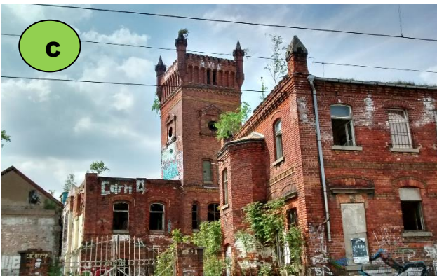
Um 1900: Leipziger Dampfmaschinen und Motorenfabrik vorm. Philipp Swiderski Heute: leerstehend
