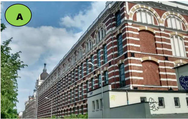
Um 1900: Sächsische Wollgarnfabrik Heute: Wohn- und Geschäftsräume, Poststelle
